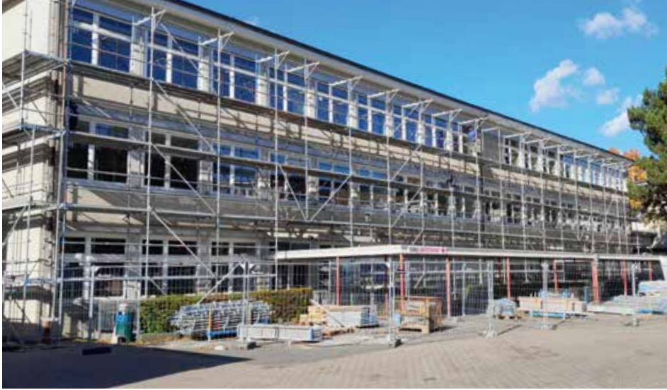
Bauzaun und Gerüst stehen. Die Sanierung beginnt mit dem Dach.
